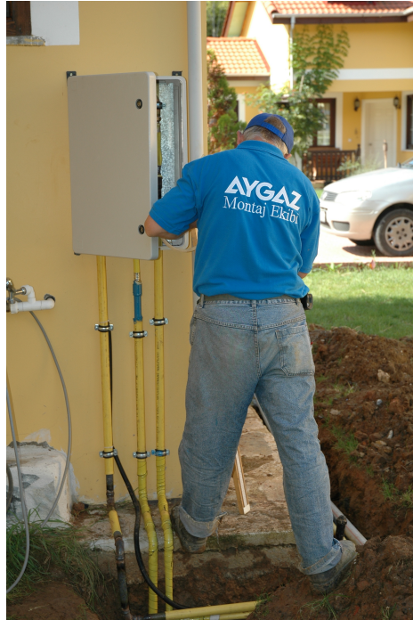
Sistemi devreye almadan önce tesisat basınç ve sızdırmazlık testi
