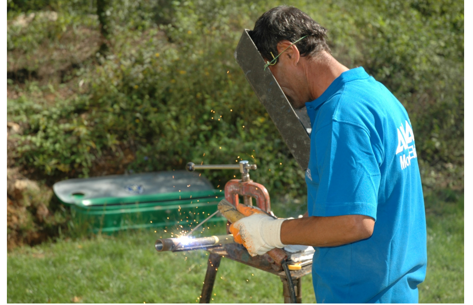
Toprakaltı borularının kaynağı
