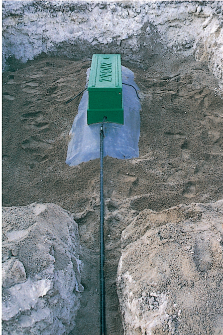
Tank - Bina arası toprakaltı boru tesisatı
