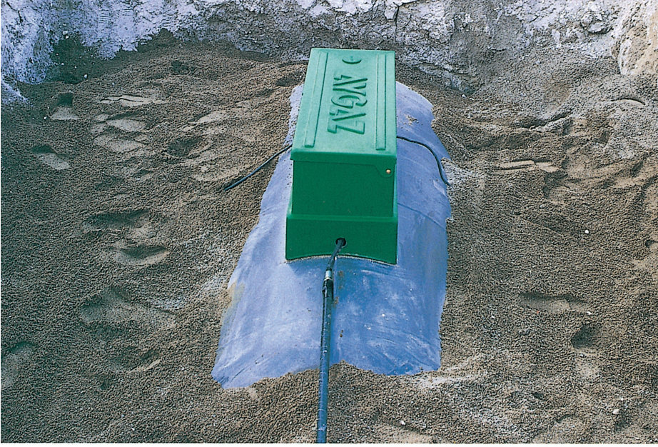
Katodik koruması ve kum dolgusu yapılmış tank
